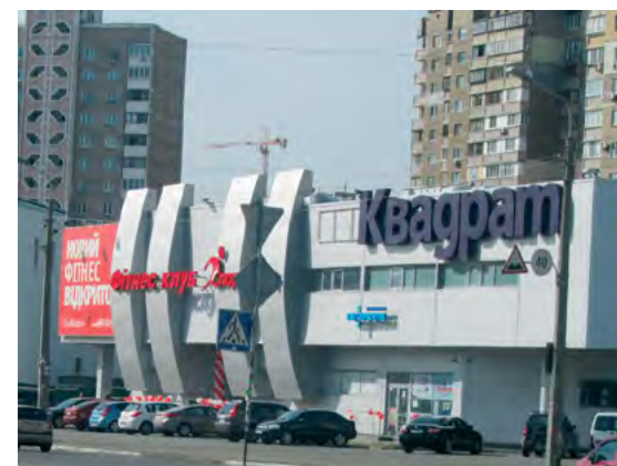
Торговельний центр «Квадрат» м. Київ, вул. Бальзака
