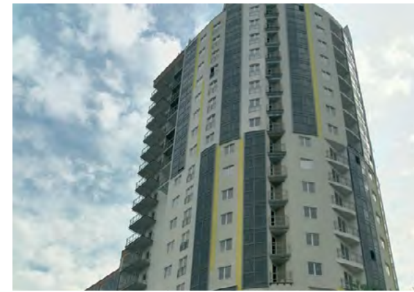
Житловий комплекс «Аксіома» м. Харків, вул. Леніна
